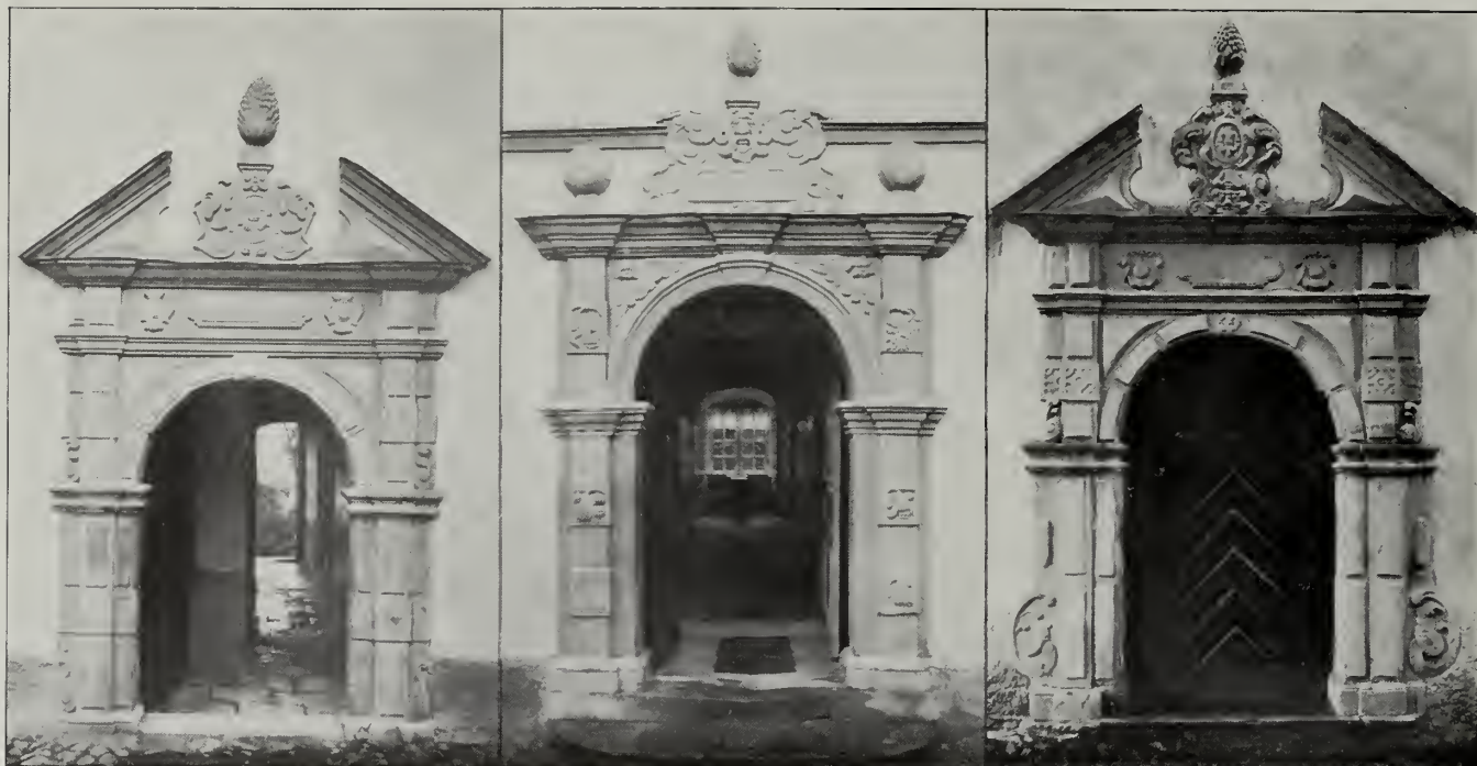
Portal å östra flygelbyggnaden dat. 1652. Portal å hufvudbyggnadens sidoparti dat. 1653.
